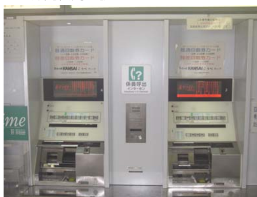
券売機間に設置したインターホン
